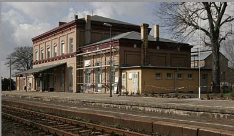
Blick aus Richtung Osten mit Wartesaal (eingestüst) und Toilettenanbau.
