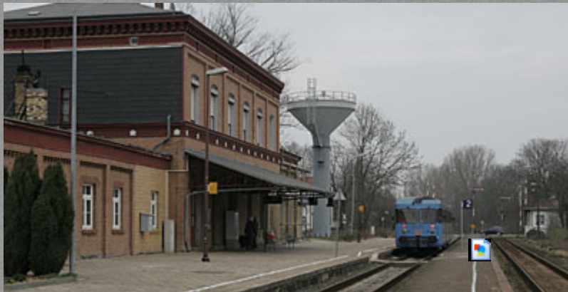
Das Empfangsgebäude mit abfahrtsbereitem Triebwagen nach Wippra.
