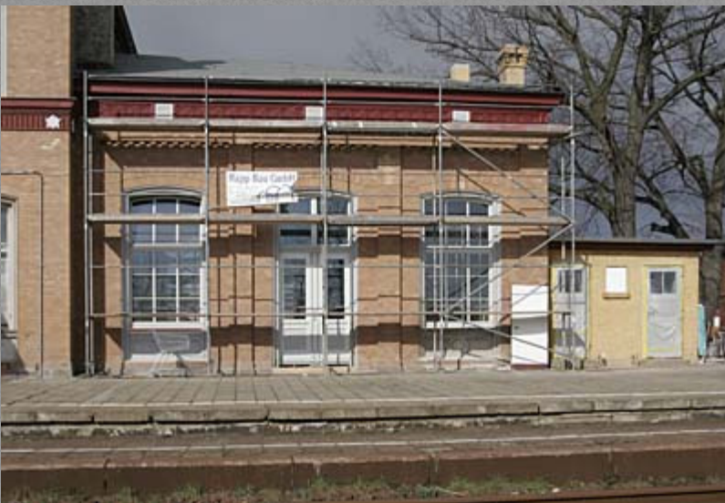
Der eingerüstete Wartesaal, rechts daneben die später angebaute Bahnhofstoilette.
